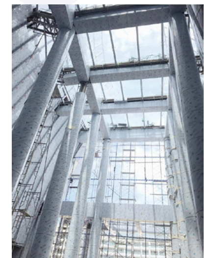
Hình 2.2b: Hình ảnh thi công sản phẩm
