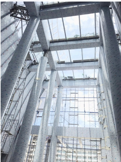
Hình 2.2b: Hình ảnh thi công sản phẩm
